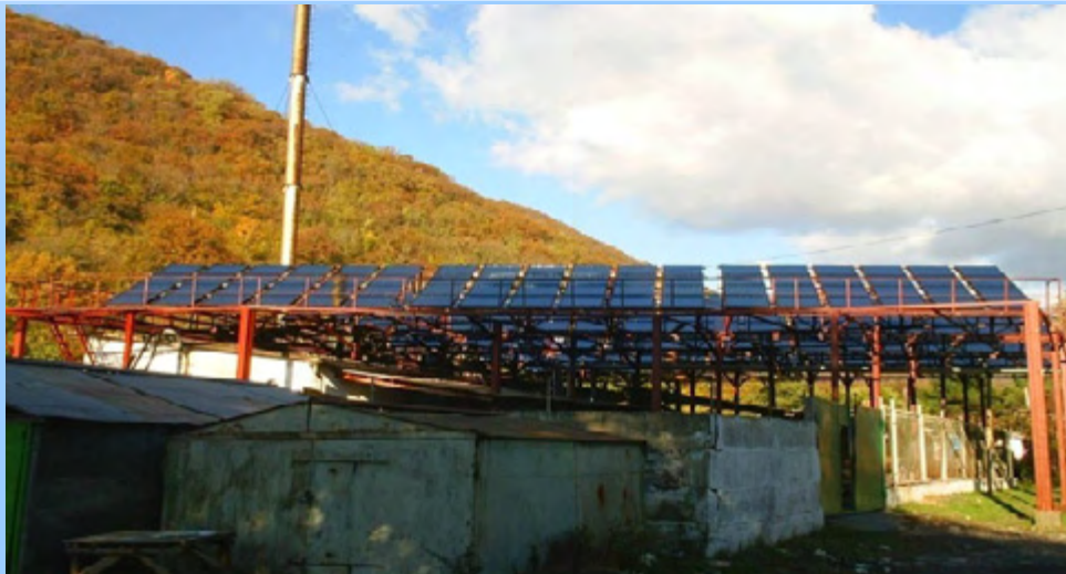
г. Анапа, солнечно-топливная котельная городской больницы, площадь солнечных коллекторов 413 кв.м.
