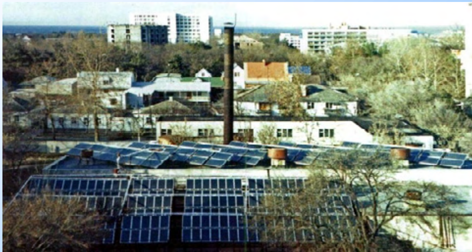
г. Анапа, солнечно-топливная котельная городской больницы, площадь солнечных коллекторов 413 кв.м.
